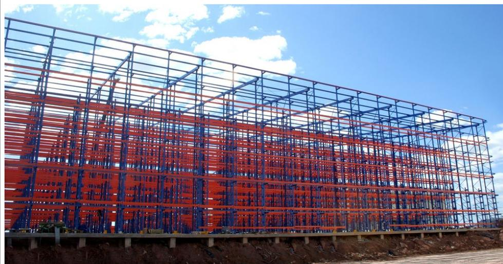
O Armazém Autoportante é um sistema criado para maximizar o rendimento de um espaço pela combinação com estruturas de armazenagem convencionais e automáticas.
